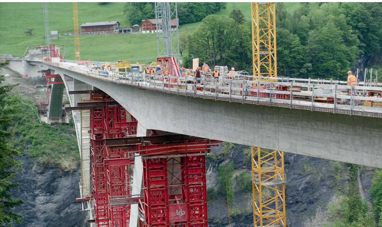
Modernste Technik im Brückenbau ...
